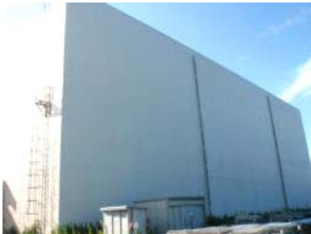
廃棄物保管棟・IIの外観
