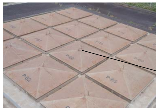
可搬式鋼製蓋の写真
