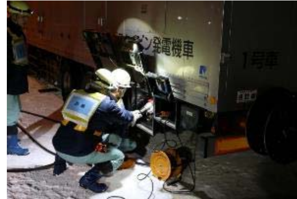
電源車へのケーブルの繋ぎこみ
