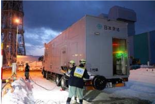
電源車から建屋にケーブルを敷設
