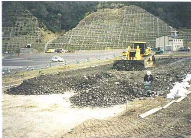
巻き出し整地状況
