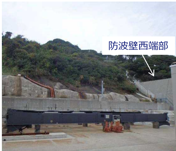
防波壁西端部 状況写真
