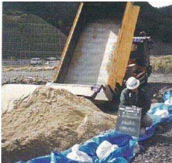
埋戻土(購入土) 現地写真(H11年)
