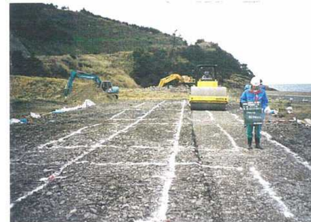
振動ローラによる転圧状況
