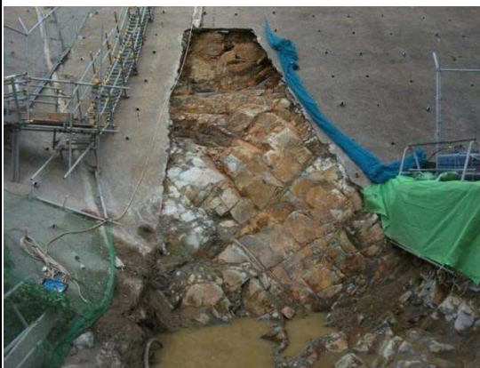
防波壁東端部 岩盤露出状況
