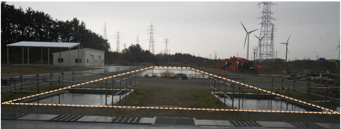
22. 旧バッチャープラント・貯水地
