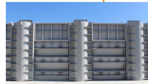
取水槽溢水防止壁 (T.P.+10mもしくはT.P.+12m)
