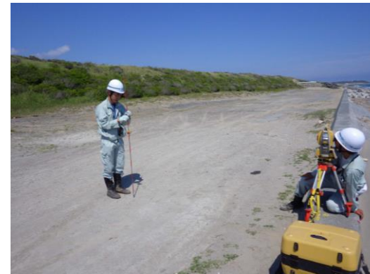
海岸線地形測量実施状況 (陸上部)
