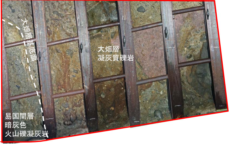
断層延長位置付近の大畑層の性状(解釈線有り)
