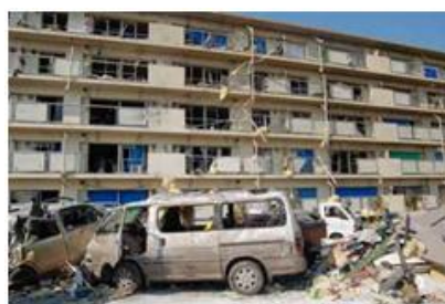
飛来物により被害を受けた住宅等
