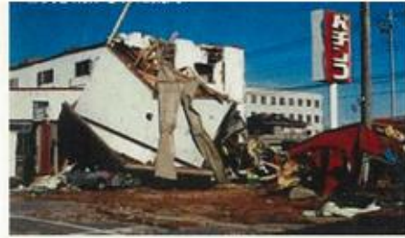
吹き飛ばされた建物
