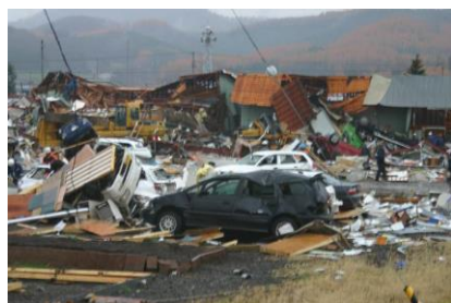
全壊した工事事務所周辺
