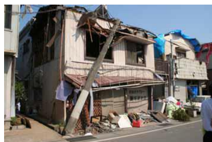
倒壊電柱に直撃された家屋
