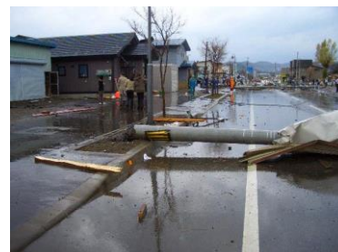
道路側へ倒壊した電柱
