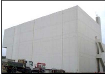
【解体分別保管棟】
