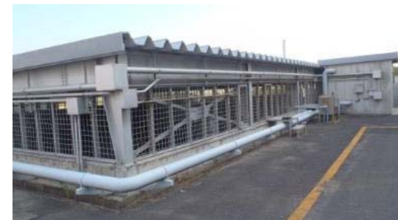
排水貯留ポンド外観
