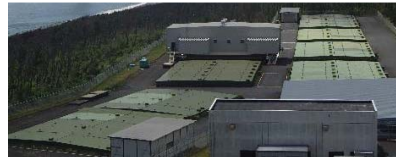
保管廃棄施設・Lの外観
