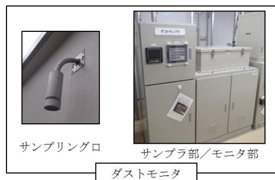
第3. 1. 1 図 モニタリングポスト等の配置図及び外観
