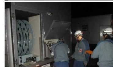
電源車へのコネクタ接続
