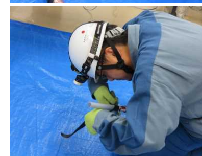
高圧ケーブル段剥ぎ・直線接続作業(個別訓練)
