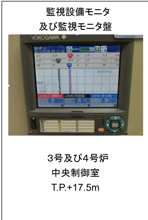
図 3-3-5 (2/2) 潮位計設備構成イメージ
