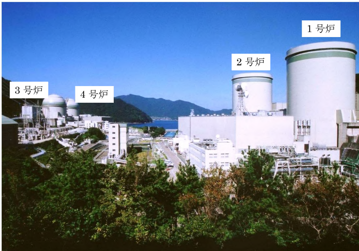
図-1-2-2 高浜発電所全景写真（1号炉側より）
