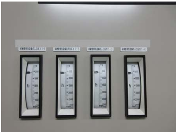
現場監視制御盤（压力測定用） 可搬型測定器（压力測定用）
