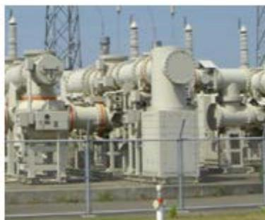
第 3-2-2 図 電気設備のフェンス（小動物対策）
