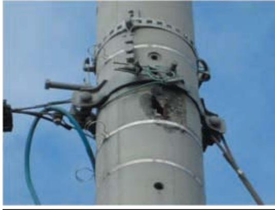
図 4-14-1 コンクリートの剥離事例<sup>(1)</sup>
