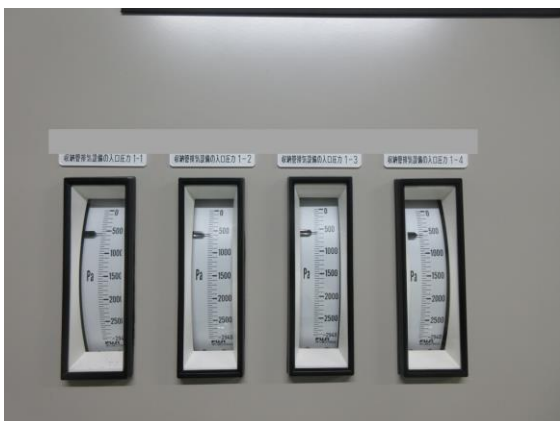
現場監視制御盤（圧力測定用）
