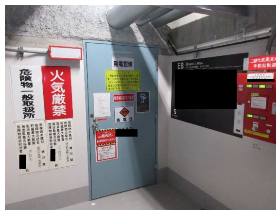
CO 2 設置室入口
