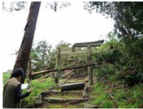
樹木の折損と鳥居の被害
