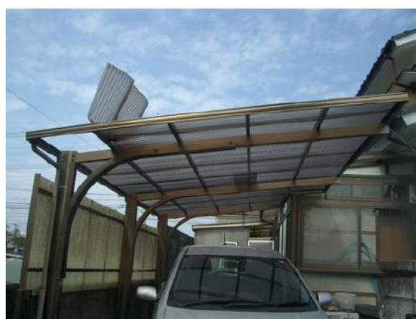
カーポート屋根の損傷
