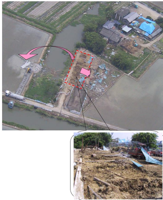
第1図 平成16年6月27日佐賀県で発生した F2竜巻による屋外屋根の被害状況 (1)
