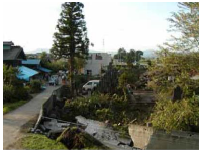
倒木（倒れない樹木もあり）
