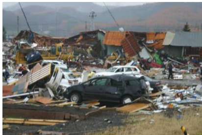
全壊した工事事務所周辺
