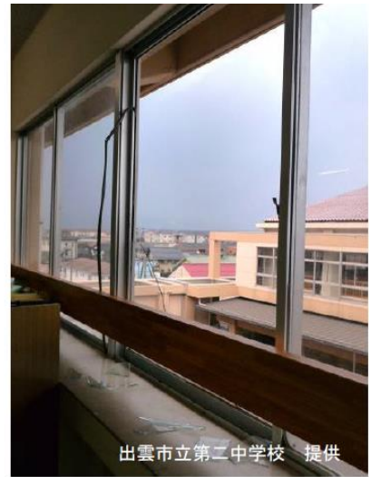
屋外に面した窓ガラス
