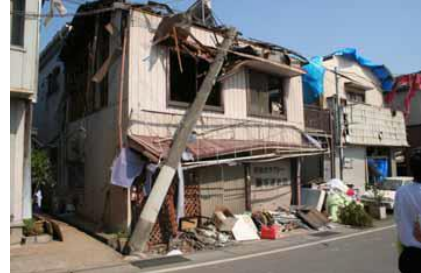
倒壊電柱に直撃された家屋
