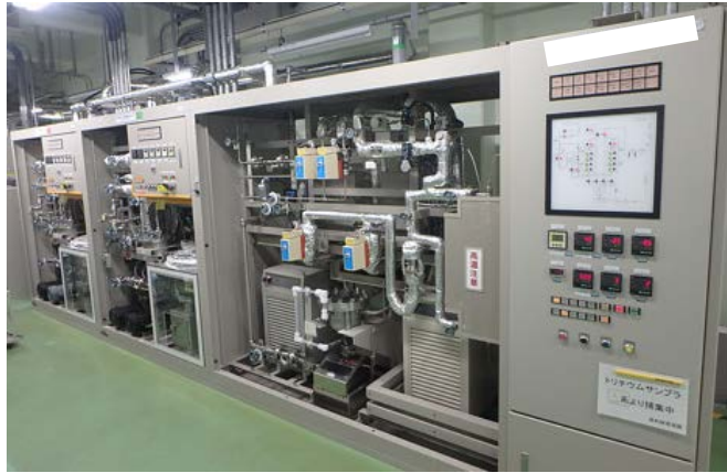
第 4 図 北換気筒（使用済燃料受入れ・貯蔵建屋換気筒）の 排気モニタリング設備の外観
