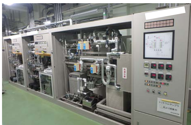
第2図 北換気筒（使用済燃料受入れ・貯蔵建屋換気筒）の排気モニタリング設備
