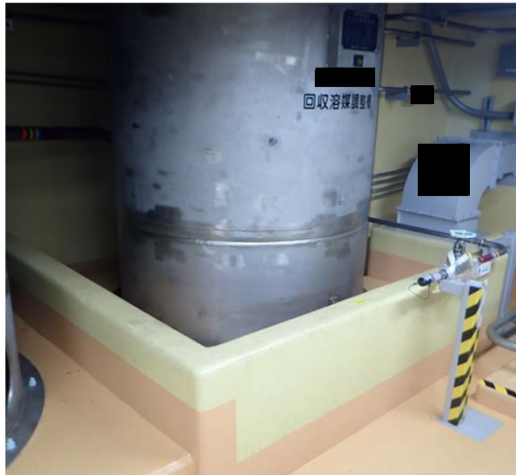
第3図 堰による拡大防止対策例
