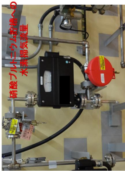
第 1. - 14 図 ウラン・プルトリウム混合脱硝建屋の水素爆発を未然に防止するための空気の供給概要 (その 2)
