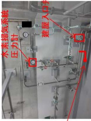
第 1. - 9 図 精製建屋の水素爆発を未然に防止するための空気の供給概要 (その 1)
