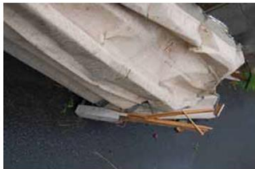
飛散した折板屋根の損傷状況
