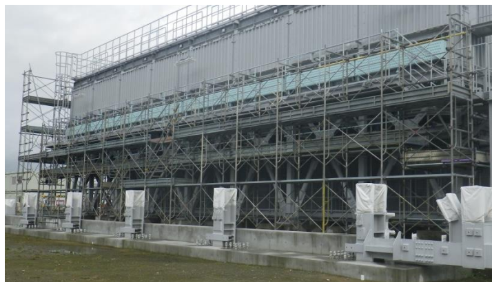
第 33 図 再処理事業所内における仮設足場の状況
