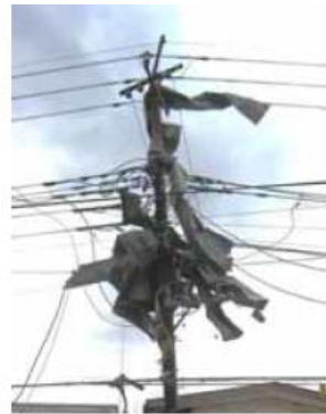
電線等に引っ掛かった飛来物（鋼板製屋根材）
