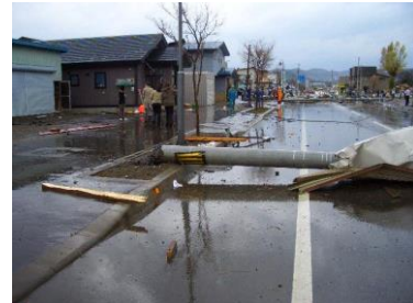
道路側へ倒壊した電柱
