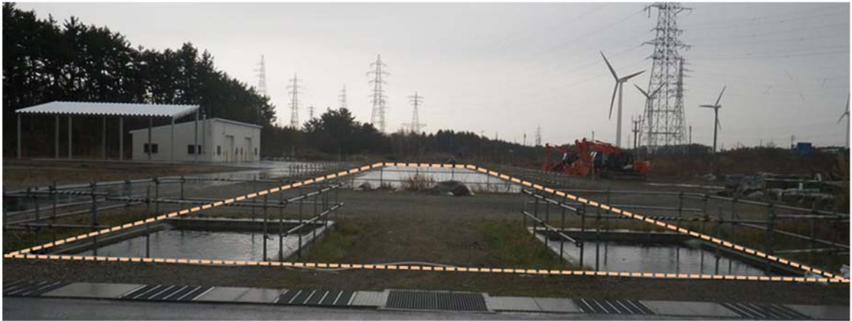
22. 旧バッチャープラント・貯水地
