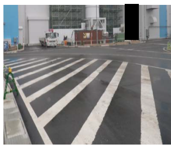
② 試薬建屋入口から西側を撮影
