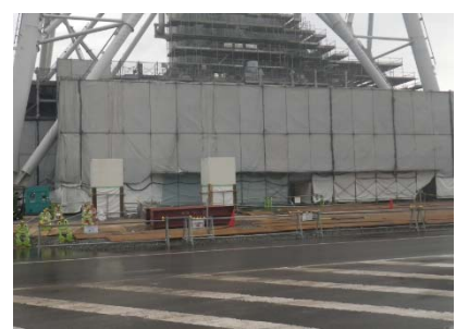
③ 試薬建屋入口から北側を撮影
