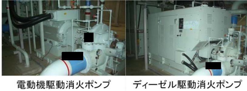
第4図. 再処理設備に配備する消火ポンプ
