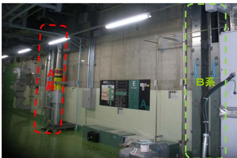
第3図 安全上重要なケーブルの分離例 （前処理建屋 地上2階南北第1廊下）
