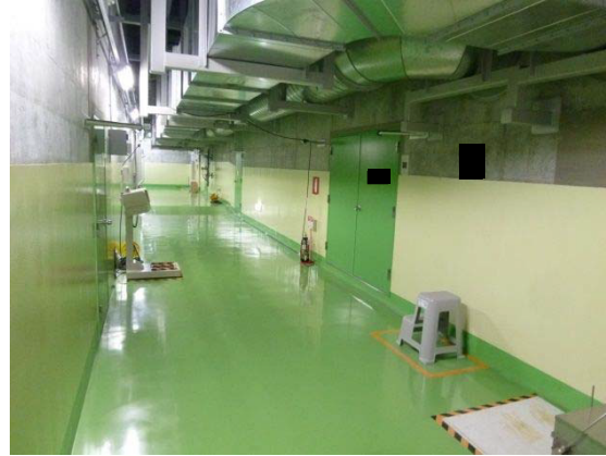
高レベル廃液ガラス固化建屋 地上1階東西第1廊下
