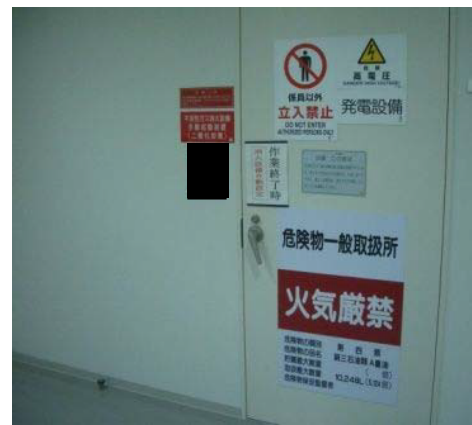
CO 2 設置室入口
