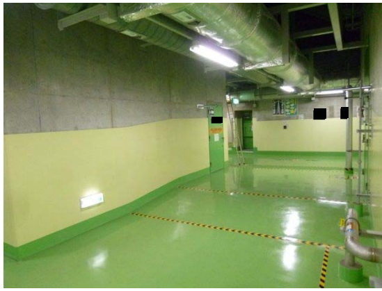
高レベル廃液ガラス固化建屋 地上1階東西第3廊下, 南北第2廊下, 南北第3廊下
