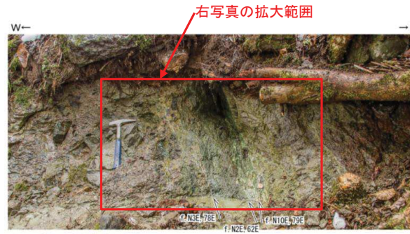
Loc. y031 東通村老部川支流 西側の泊層凝灰角礫岩と東側の泊層安山岩質溶岩とを境する断層。
