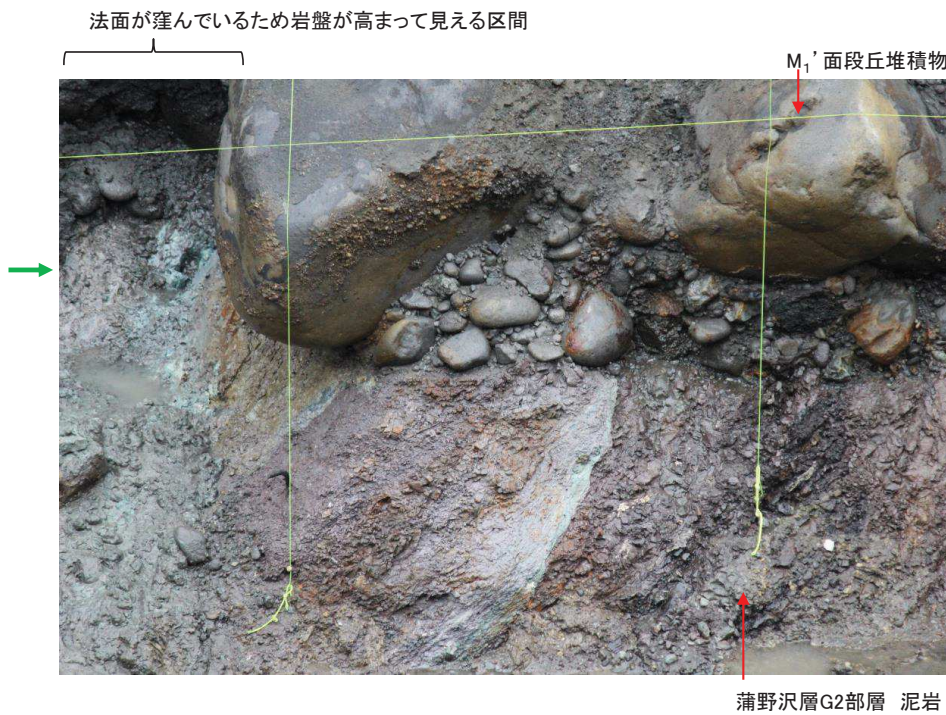
写真A 蒲野沢層中の岩盤上面の性状
