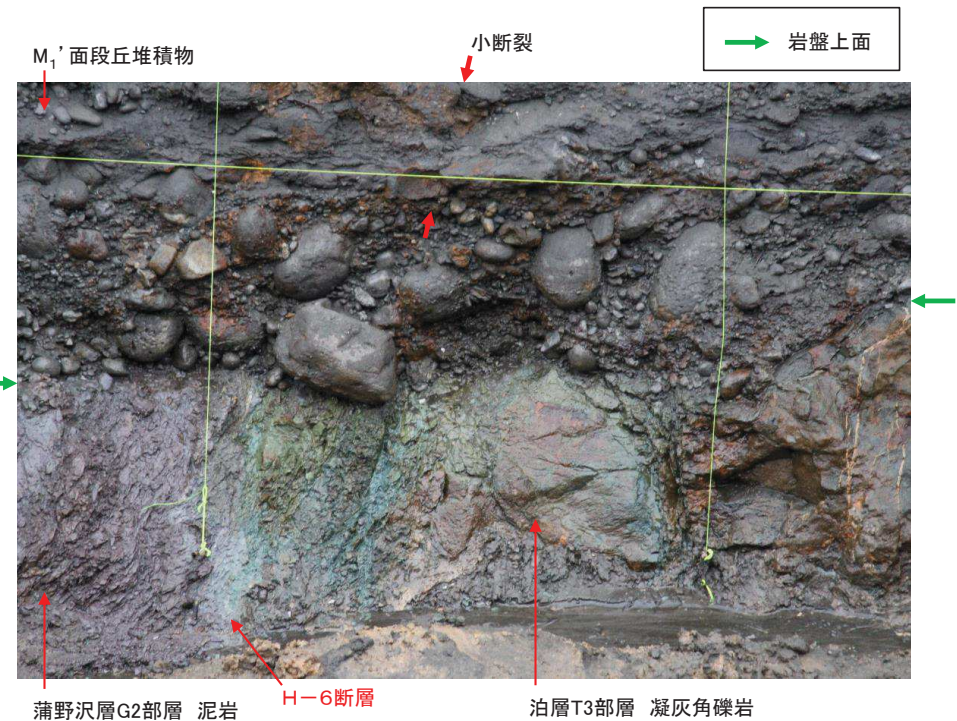
写真B H-6断層近傍の岩盤上面の性状
