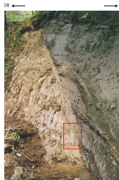
断層部拡大写真 (左写真の赤枠部分) 断層面は癒着しており、断層面近傍に顕著な破碎は認められない。
