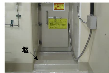
管理区域外伝ぱ防止堰の写真
