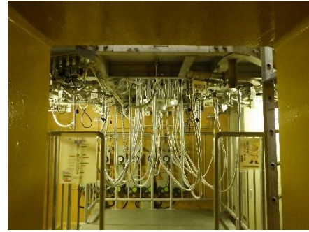
制御棒駆動装置
