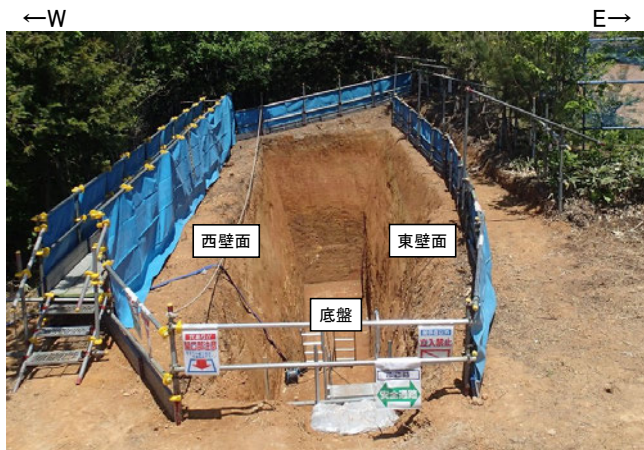
トレンチ状況写真(南側から撮影)
