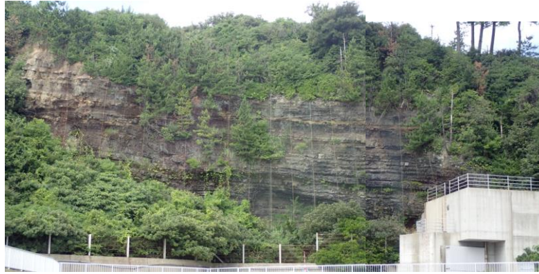
図 2 - 8 ( 4 ) 防波壁 ( 東端部 ) 露頭状況 P4 斜面部
