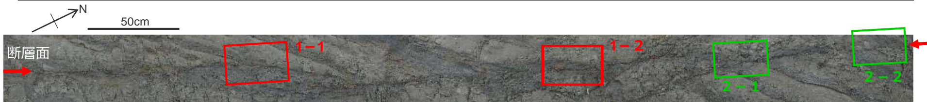
ゆ着型断層と開離型断層両方の性状を示す断層 (逆断層)
