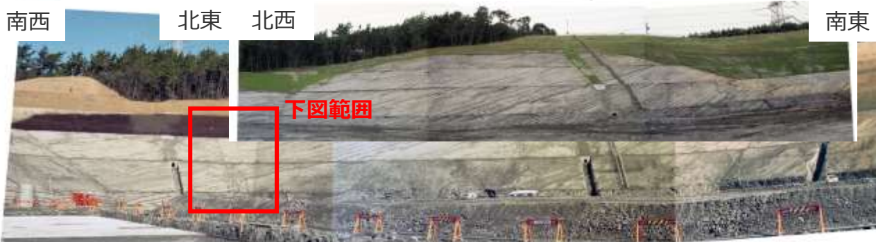
5号炉敷地造成法面写真（北側法面）
