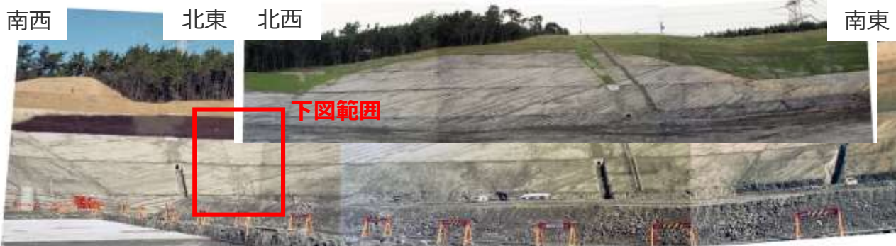
5号炉敷地造成法面写真（北側法面）
