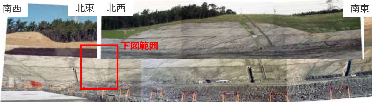
5号炉敷地造成法面写真（北側法面）
