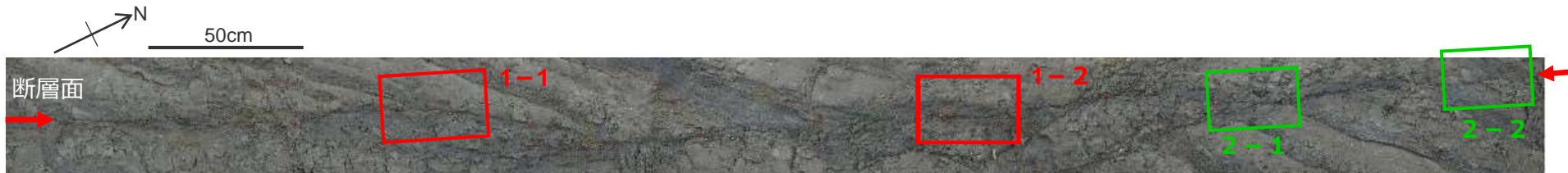
ゆ着型断層と開離型断層両方の性状を示す断層（逆断層）
