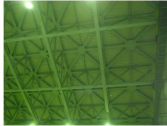
原子炉建物天井
