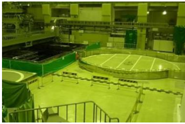
原子炉建物内オペフロ全体
