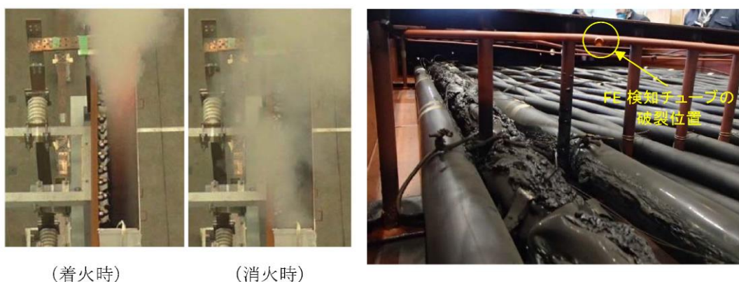
第11図 試験V2における発火・消火時の状態
