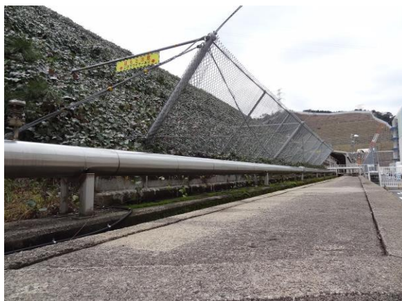
屋外消火配管の地上化
