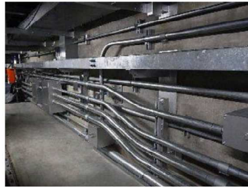
ケーブルトレイ，電線管の例
