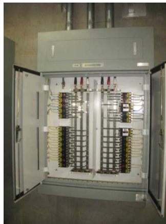
配線用遮断器の例 (ブレーカー)
