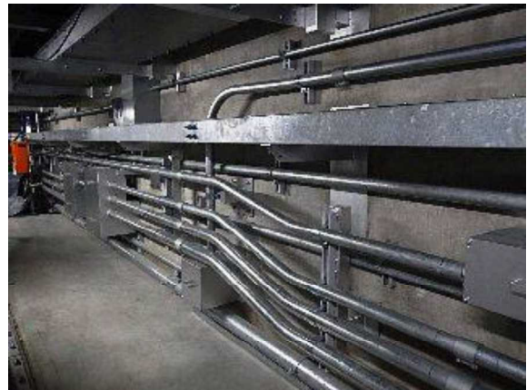
ケーブルトレイ，電線管の例
