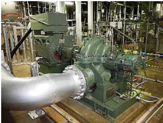
ポンプ，配管，支持構造物の例
