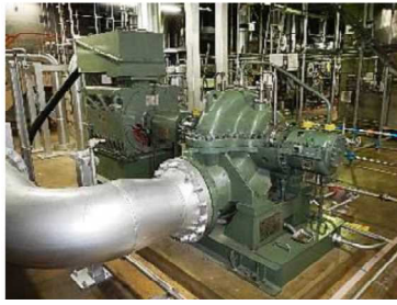
ポンプ，配管，支持構造物の例
