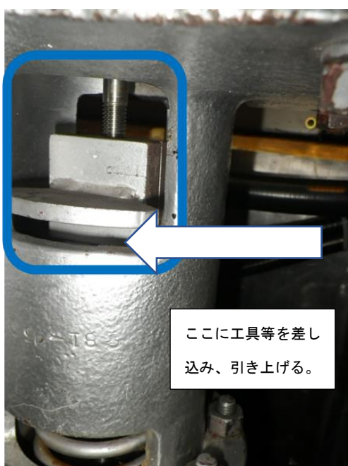
サイフォンブレーク弁閉状態
