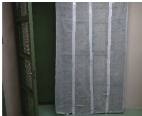
仮設フィルタ取付中の写真イメージ
