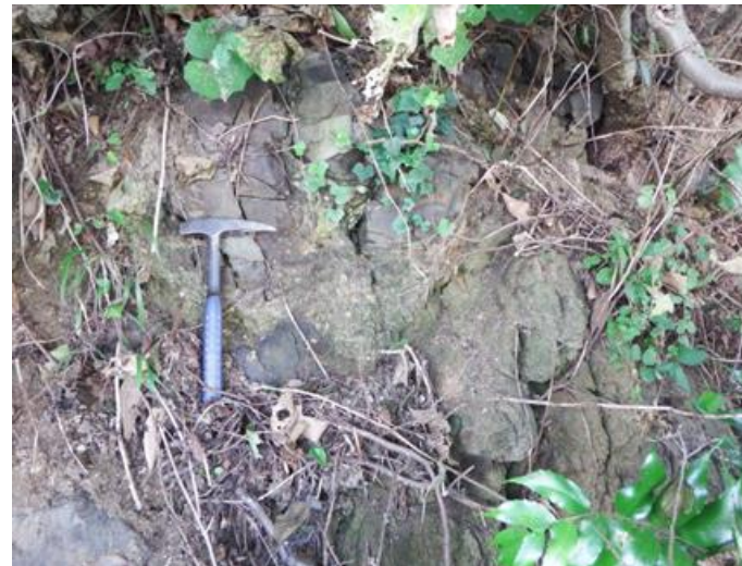
P2 県道より山側の斜面では堅硬な岩盤が露出している。
