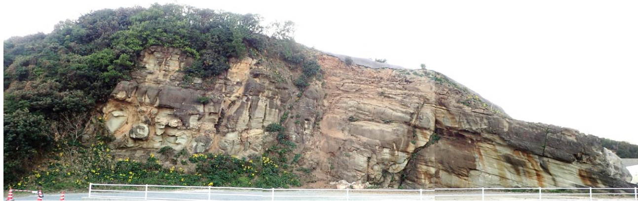
開削面露頭全景（2019年11月6日撮影）
