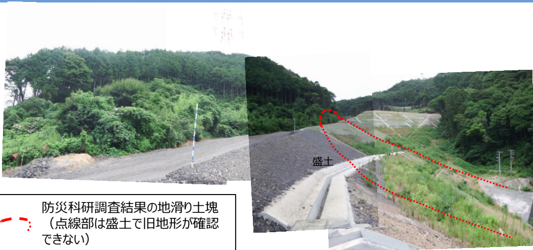
P2 地滑り地形③の斜面状況 防災科研調査の地滑り土塊の大部分は工 事用道路の盛土で被覆されている。土塊背 後に滑落崖と判断できる地形要素は認めら れない。
