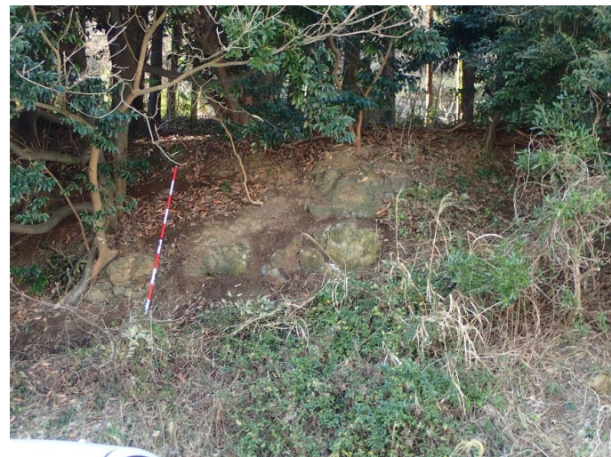
P4 P3の50m南方の山側斜面は堅硬な岩盤が露岩している。
