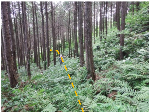
P2 地滑り土塊内部に認められる滑落崖末端部の位置は、西側ではほぼ一定の標高をなすが、東側では次第に低くなる。滑落崖と地滑り土塊の境界は明瞭である。
