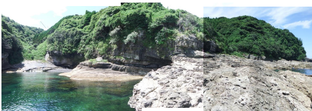
P4 海岸部には凝灰岩の連続露頭があり、層理面の走向傾斜はN57W 28Nである。緩み構造の認められないC M 級岩盤であり、地滑りの影響はないと考えられる。
