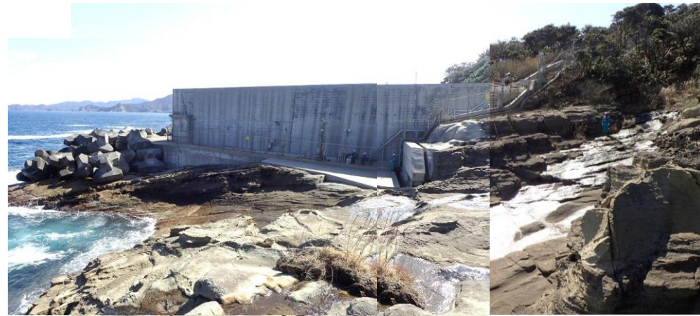
防波壁（西端部）
