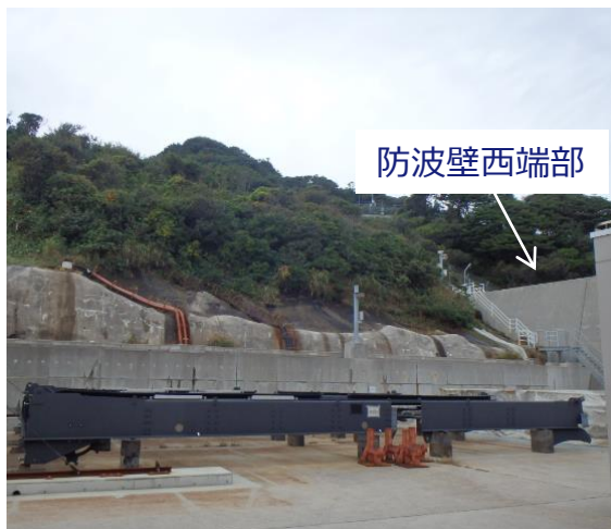
防波壁西端部 状況写真
