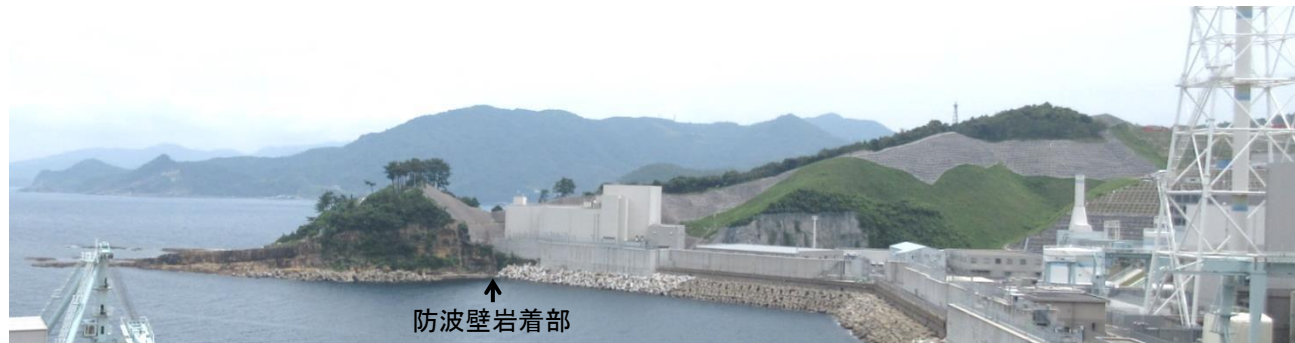
P1 防波壁（東端部）全景 岩着部は尾根の先端を開削した法面に位置する。
