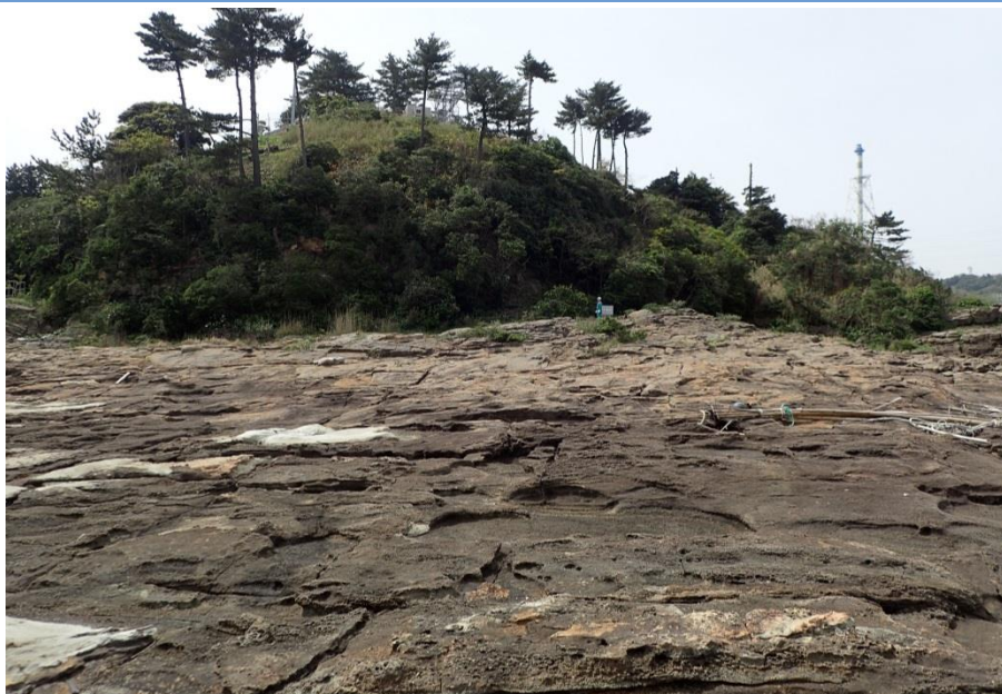
P1 地山北端部 堅硬な火山礫凝灰岩が広く露出する。
