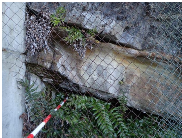
図2-8 (19) 防波壁(東端部)露頭状況 P19 防波扉北側岩着部拡大
