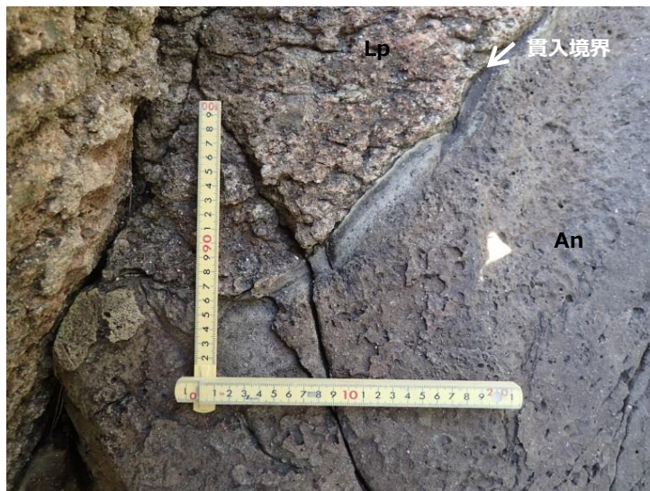
図2-8 (13) 防波壁(東端部)露頭状況 P13 安山岩岩脈上盤境界 貫入境界は火山礫凝灰岩に密着し、安山岩側に急冷縁あり。
