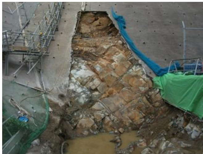
図 2-19 防波壁東端部 岩盤露出状況
