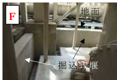
図 6 堰周りの状況 (A - 構内排水処理装置 塩酸貯槽)
