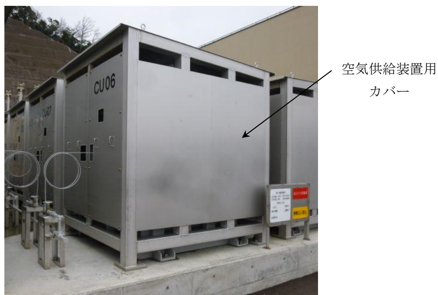
第1図 空気供給装置用カバー 外観
