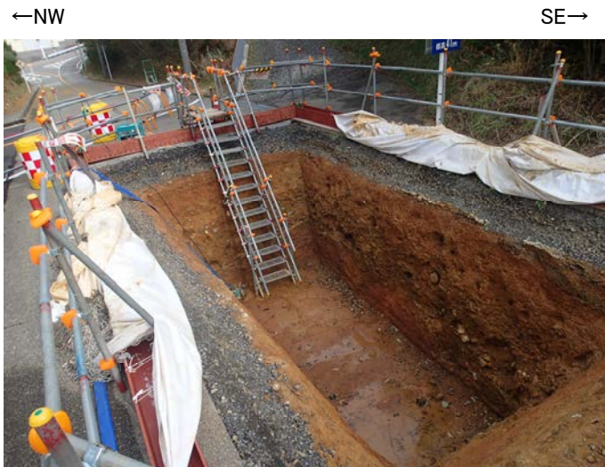
トレンチ状況写真(南西側から撮影)
