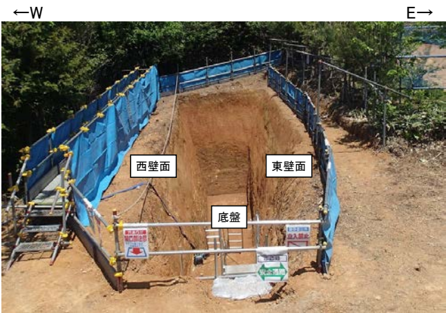
トレンチ状況写真(南側から撮影)
