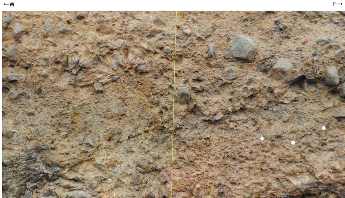
北面調査箇所 拡大写真
