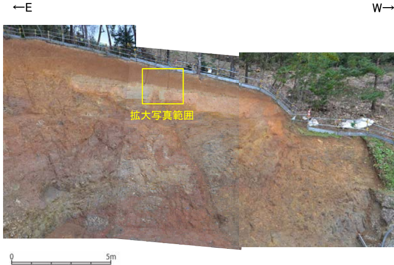
法面写真(南側法面)
