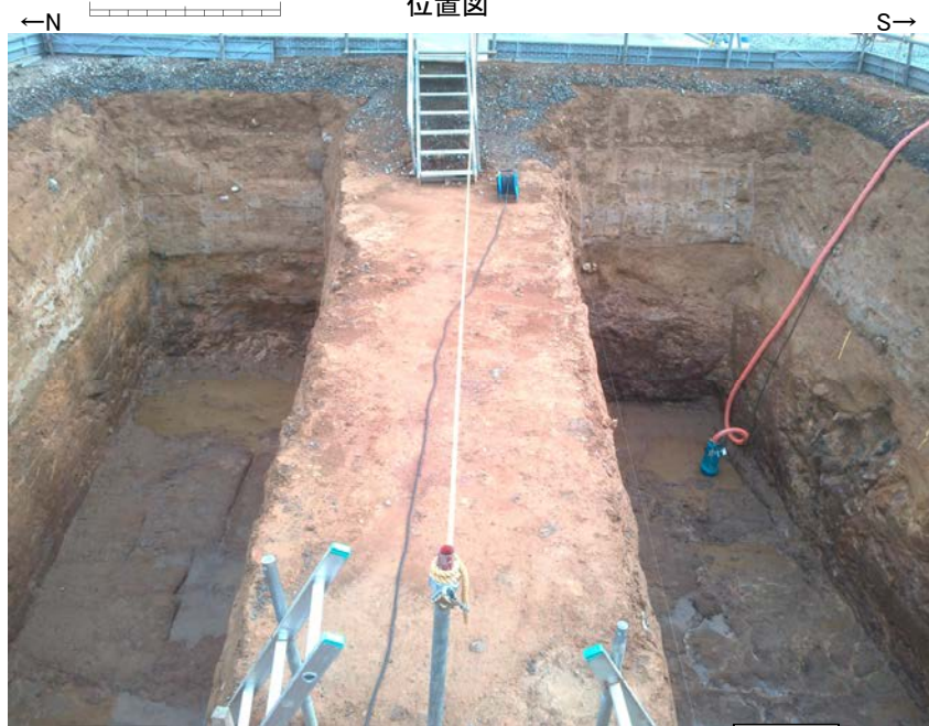
トレンチ状況写真(西側から撮影)
