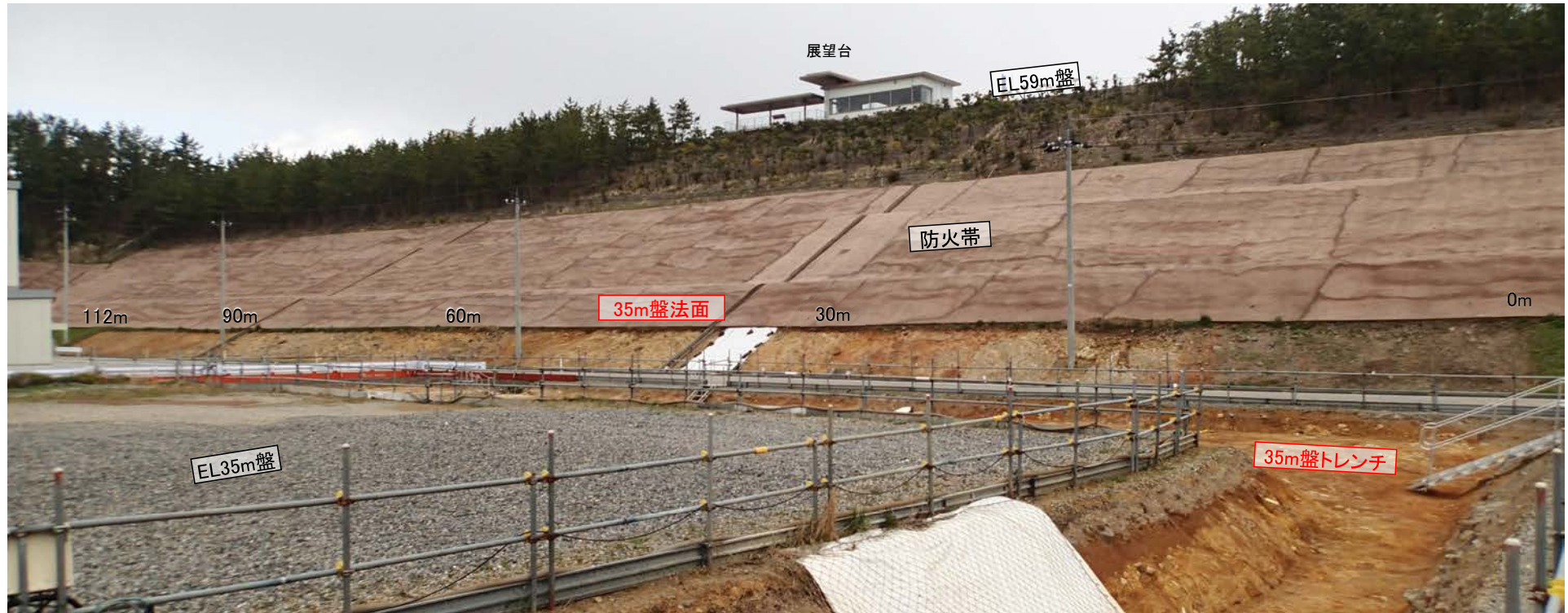
35m盤トレンチ及び35m盤法面 全景写真
