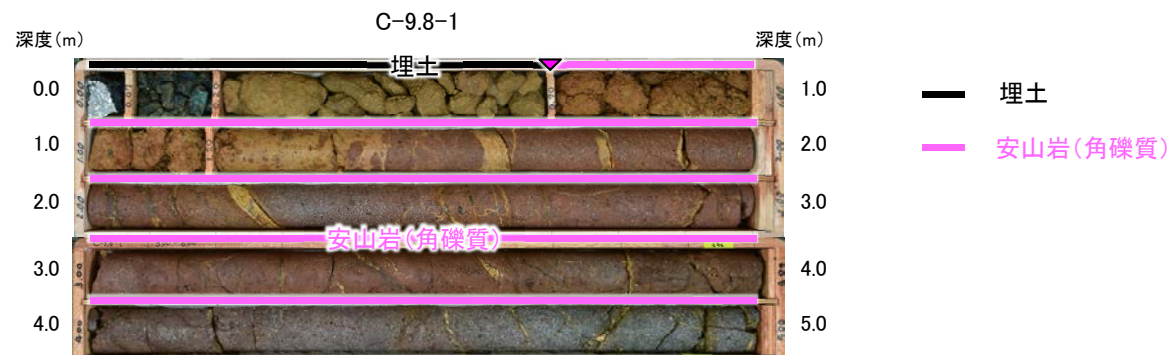
コア写真(深度0~5m) ▼ 埋土と安山岩(角礫質)の境界 (EL21.83m)
